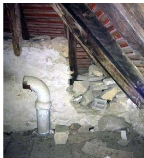
Figure 7 : Accès permettant aux chiroptères de transiter entre les combles et l'appentis.
